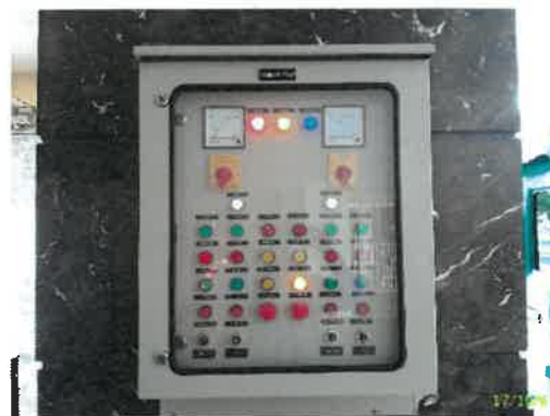
ตู้ควบคุมน้ำก่อนปล่อยออกนอกโครงการ
